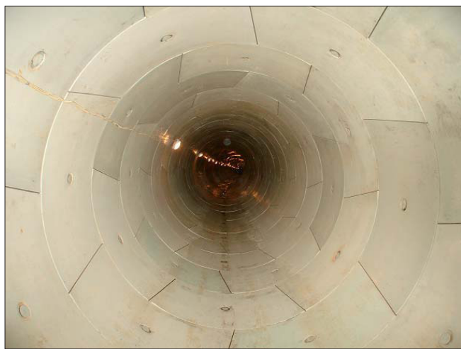
Рис. 1. Участок Царицынского канализационного коллектора
